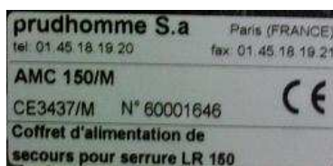
Figure 5 : Plaque signalétique du coffret d'alimentation de secours
