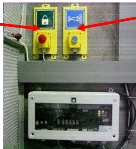
Figure 4 : Système de désactivation du dispositif anti-déverrouillage
