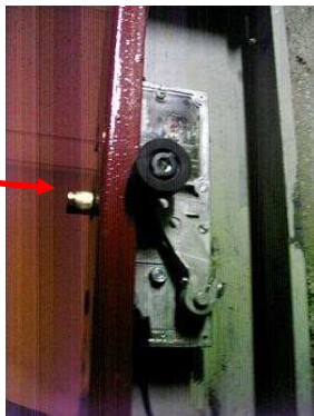
Figure 1 : Dispositif de verrouillage de la porte palière (vue de la gaine)
